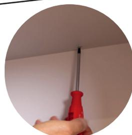
(3) Placez le meuble à l'endroit désigné, faites glisser le meuble contre le mur de sorte que le boulon repose dans le trou du support. Serrez la vis sans tête à l'intérieur du meuble.
