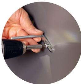
(2) Percez la cheville (B) sur le mur et vissez le boulon avec la languette (A).
