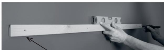
(1) Monter la barre de suspension avec le biseau vers le haut et horizontalement par rapport au mur à l'endroit prévu où la box doit être suspendue. Utilisez à cet effet le matériel de fixation fourni. Selon le support/mur, il peut être nécessaire d'ajuster le matériel de fixation, les chevilles et les vis. Les chevilles et les vis fournies conviennent aux murs en briques et en béton.
