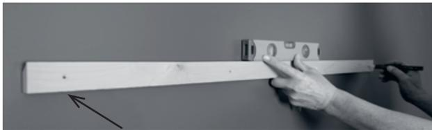
(1) Montieren Sie die Hängeleiste mit der Abschrägung nach oben und zur Wand waagrecht an die vorgesehene Stelle, an der die Box hängen soll. Verwenden Sie hierfür das mitgelieferte Befestigungsmaterial.
